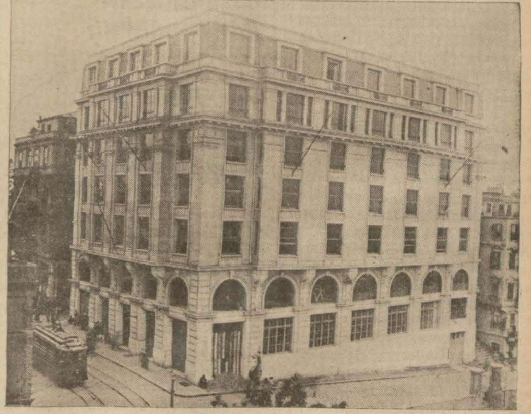
Elektrik ve Tramvay şirketleri binası
